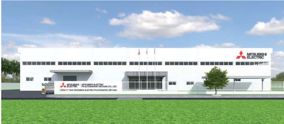
Nhà máy Mitsubishi Electric FP Automation Việt Nam tại Khu Công nghiệp Thăng Long II
